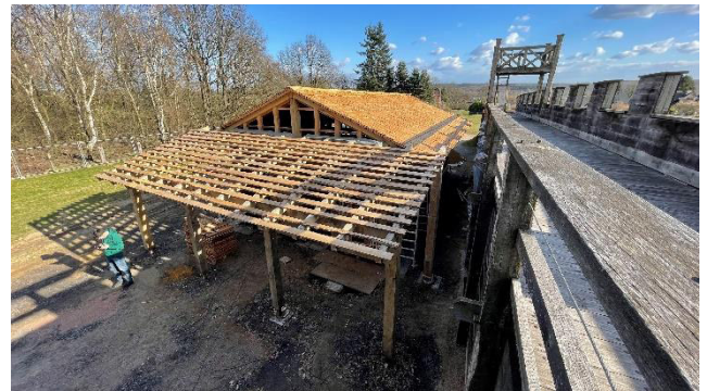
Für das Dach kamen insgesamt ca. 170 Kubikmeter Holzschindeln zum Einsatz.
