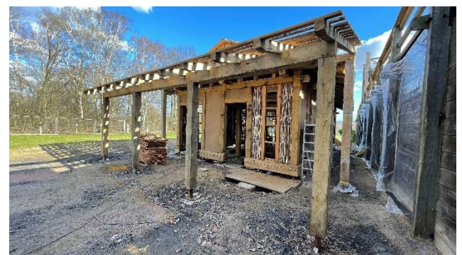
Beim Lehmverputz können die Besucher:innen selbst Hand anlegen und den Bau vollenden.
