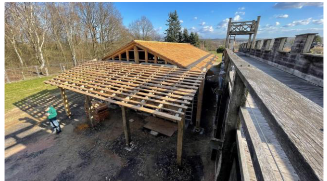
Für die Dachschindeln des neuen römischen Wachhauses kamen 15 Kubikmeter Eiche und 2,5 Kubikmeter Lärche zum Einsatz.
